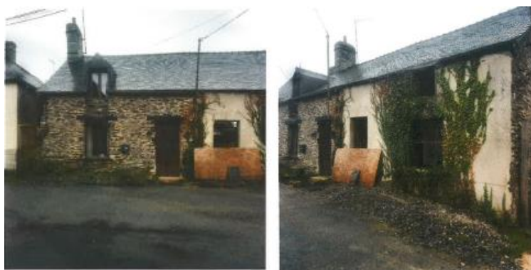
Photos prises depuis la rue (actuelle maison d'habitation et bâtiment adjacent)
