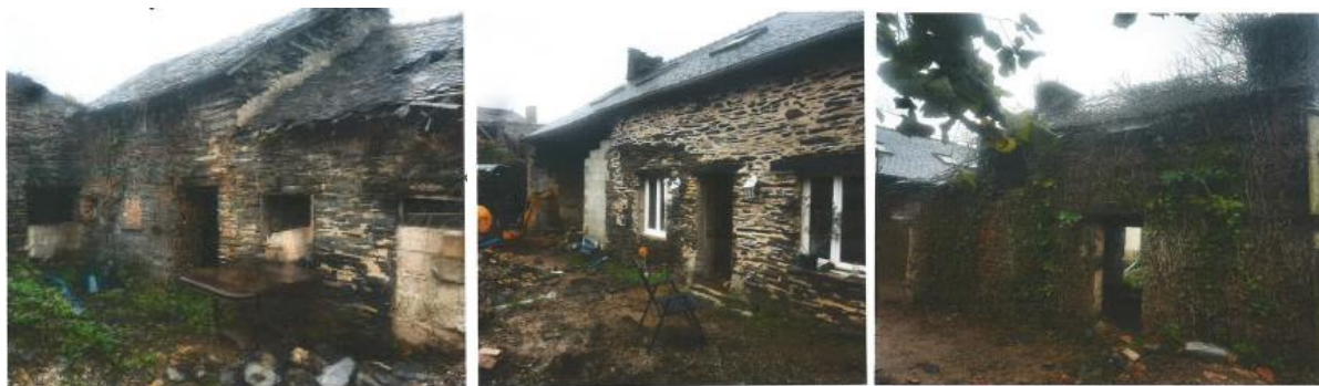
Photos prises depuis l'intérieur du terrain des bâtiments existants
